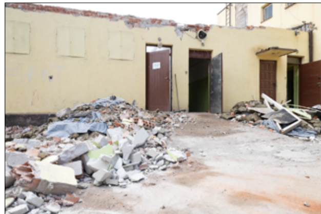
Do takich widoków na razie musimy się przyzwyczaić. Niebawem budynek żłobka zostanie rozbudowany i zmieni swój wygląd.
