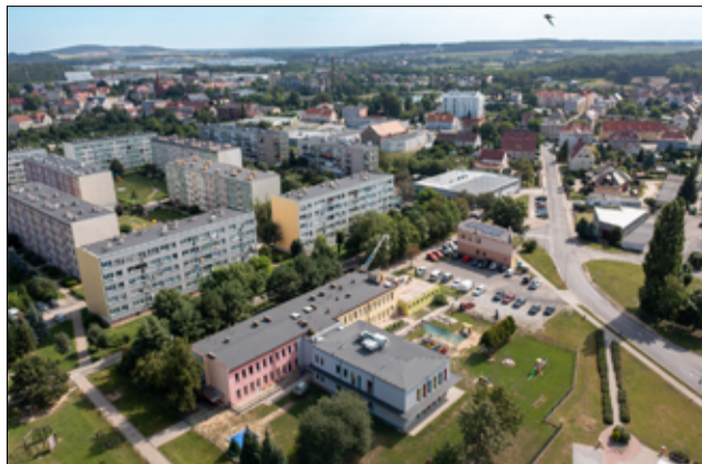
W ramach prowadzonych prac przeprowadzona została rozbiórka nieużytkowanego komina.
