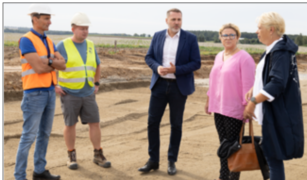
Burmistrz Przemysław Sikora wraz z radną i sołtys Przyłęgowa oraz sołtys Mielęcina spotkał się z wykonawcą inwestycji, aby porozmawiać o przebiegu realizowanych prac.
