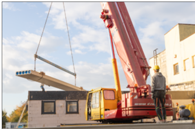
Na terenie powstającego obiektu ekipa remontowa pracowała przy ułożeniu stropu.
