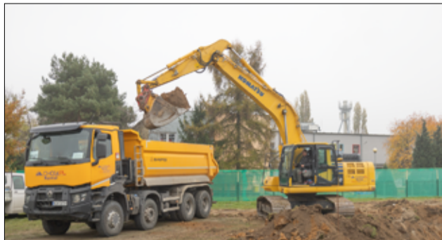
Prace przy budowie nowego obiektu nadzorują burmistrz Przemysław Sikora oraz pracownicy Referatu Inwestycji UM Żarów.
