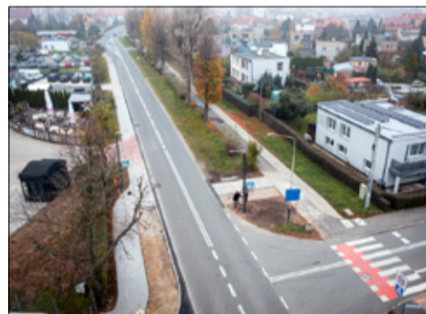
Przy ul. Armii Krajowej trwa budowa bezpiecznego i oznakowanego przejścia dla pieszych.
