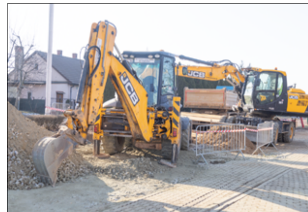
Inwestycja potrwa jeszcze kilka miesięcy, a cała zniszczona w wyniku prac drogowych infrastruktura, zostanie odtworzona i wyremontowana na nowo.
