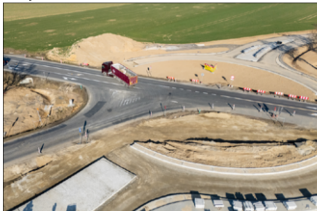
Wprowadzona na czas budowy ronda tymczasowa organizacja ruchu nie wprowadziła żadnych utrudnień komunikacyjnych.
