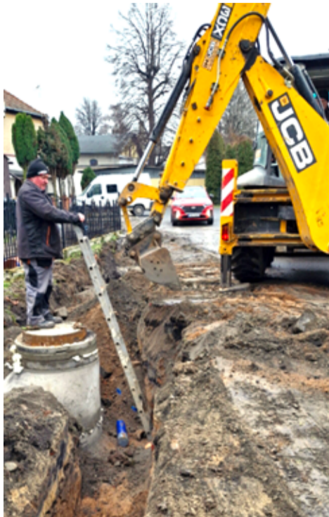
Zakończyły się prace kanalizacyjne przy ul. Sportowej w Żarowie. Inwestycję realizował ZWiK Sp. z o.o. w Żarowie.
