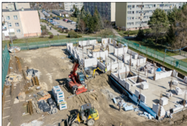
Prace przy budowie hotelu i siłowni nabierają tempa, choć na większe efekty trzeba jeszcze trochę poczekać.
