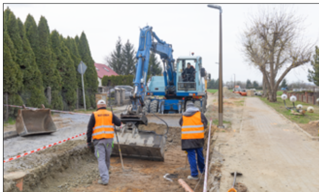
Trwają prace drogowe na odcinku drogi przy ul. Piastowskiej w Żarowie. Już za kilka miesięcy pomiędzy ulicą Wiejską a Górnicałą powstanie nowa droga.
