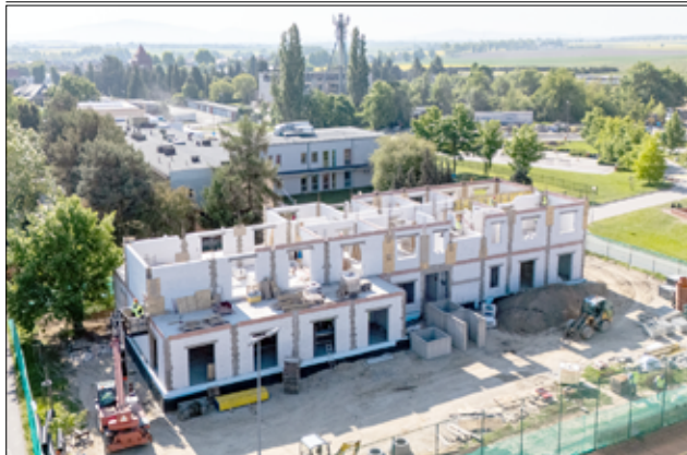
Prace przy budowie nowego sportowego budynku są realizowane zgodnie z projektem i terminowo.
