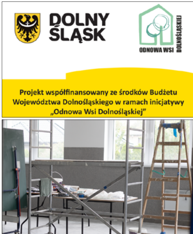
Trwają prace remontowe budynku świetlicy wiejskiej w Mielęcinie.
