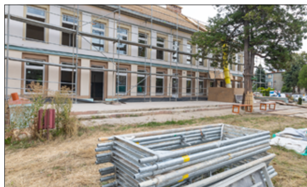
W budynku SP Żarów przy ul. Ogrodowej prowadzone są prace przy termomodernizacji. Remont potrwa do końca roku i budynek szkolny będzie wyglądał jak nowy.
