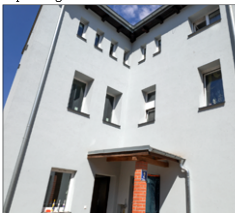
Po remoncie budynek już nie straszy swoim wyglądem.
